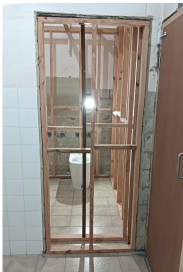
Remonta modernizācijas progress.
